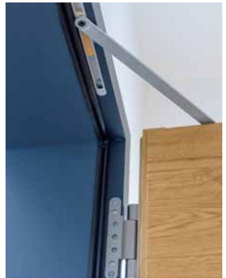
Schutz vor eindringendem Rauch bieten dicht- und selbstschließende Türen. Möglich durch die Montage von Obentürschließern.
